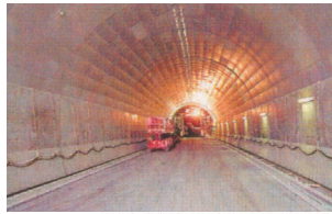
Die Südröhre mit zwei Fahrspuren: An der Wand werden die Brandschutzplatten montiert. FOTO: DW
