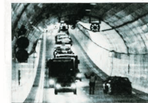
Der Wesertunnel bei Bremen gehört zu den Tunneln, die mit „sehr gut“ abschnitten. Foto: dpa
